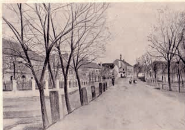
Švehlův statek v Hostivaři s mlýnem a pekárnou.
